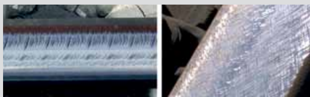
Rails meulés de manière agressive avec ondulations et bleuissement | Surface du rail immédiatement après meulage HSG
