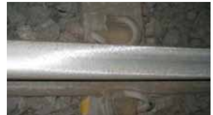
Rails avant, pendant et après le traitement HSG
