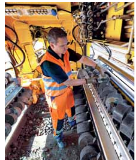
Remplacement des meules
