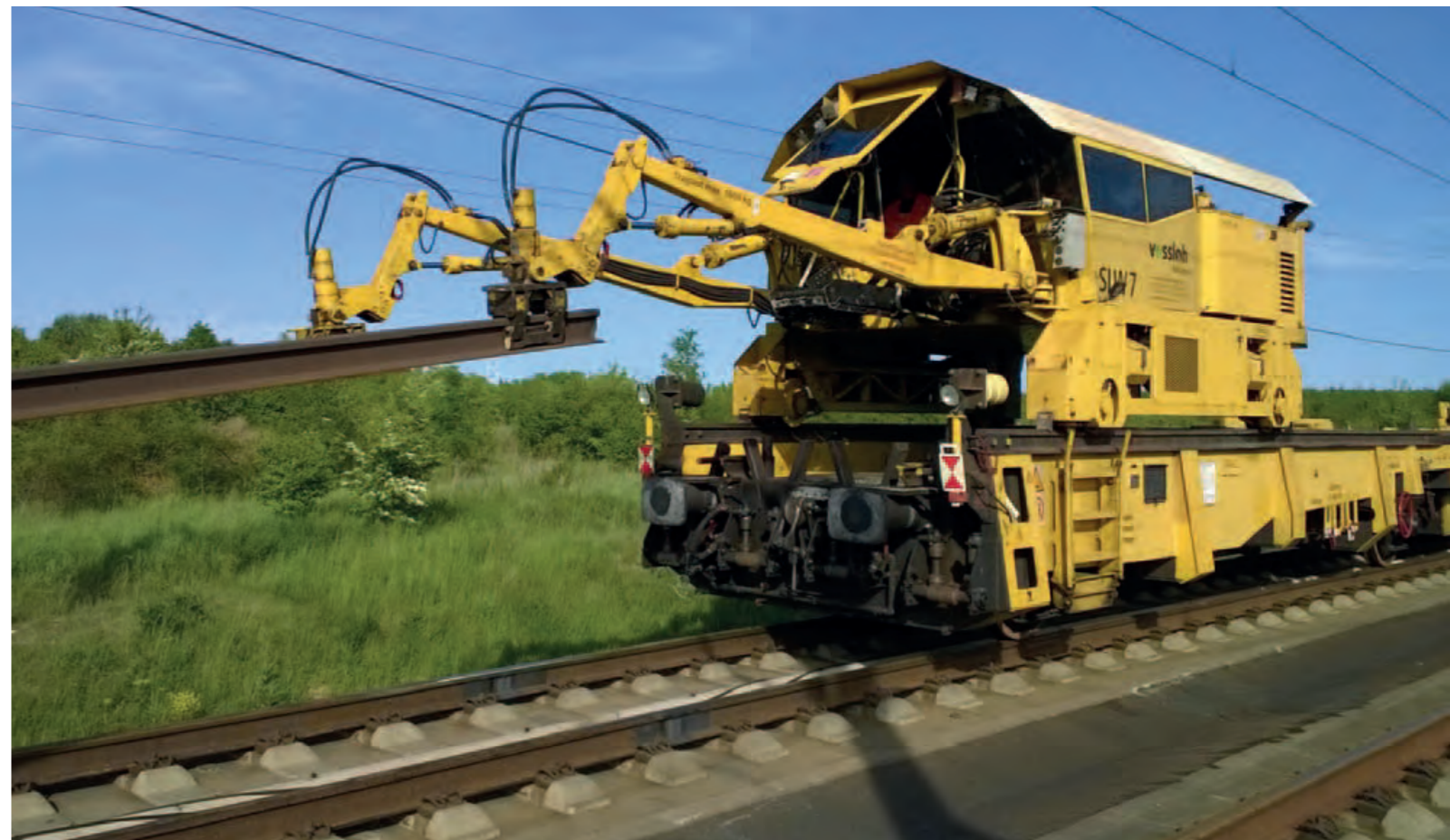
Vollautomatisch: Die Langschienen werden sicher gegriffen und direkt auf die Schwellenköpfe oder in der Gleismitte abgelegt
