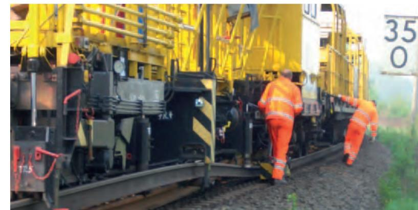
Neuschienen sollten in Längen von 180 m bestellt werden. Das verringert die Zahl der Schweißungen, erhöht das Arbeitstempo und nutzt die Kapazitäten der Langschienentransporteinheit optimal. Die randentkohlte Zone (Walzhaut) sollte möglichst stationär entfernt werden. Dadurch entfällt der Einsatz eines Schienenschleifzuges.
