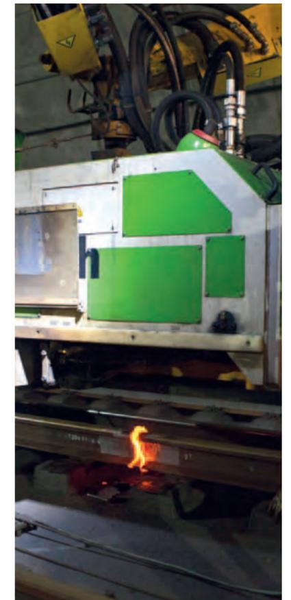
FrISCHE Schweißnaht unmittelbar vor dem Grobschliff. Die Feinarbeitung erfolgt nach dem Erkalten der Schweißung.
