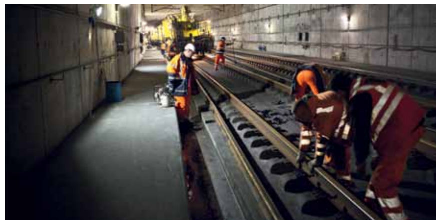
Renouvellement de rails dans un tunnel près de Francfort
