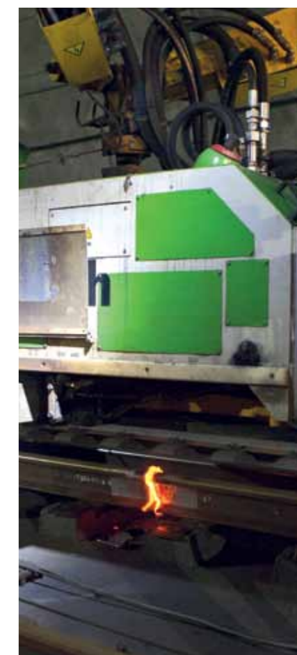
Nouveau bourrelet de soudure directement avant l'ébavurage. Le travail de finition est effectué après le refroidissement de la soudure.
