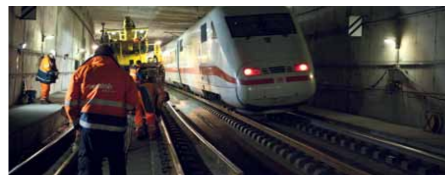
Renouvellement de rails dans un tunnel – circulation normale sur la voie voisine
