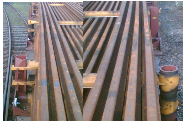
ohne Steckbolzen: Schienen gleiten quer frei
