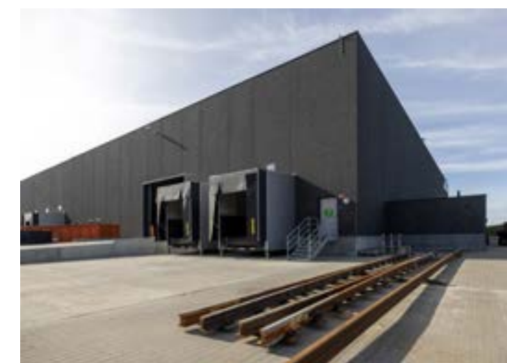
Växelfabriken ligger i Taulov Dry Port – Danmarks största transportknutpunkt – med enkla förbindelser till motorväg, järnväg, Billunds flygplats och Fredericias hamn. Den 3 000 kvadratmeter stora fabriken är belägen i direkt anslutning till Banedanmarks produktionsanläggning för betongsliprar.
