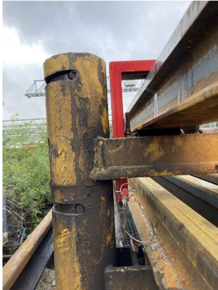
Abbildung 6: Schienensicherungsbügel in die Öffnung des Rollenbocks gesteckt und gesichert
